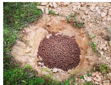
图 B.8 种植穴底部铺设陶粒
