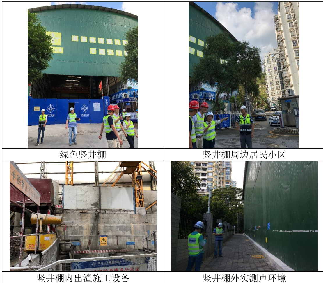
图 1 某轨道施工绿色竖井棚降噪效果
