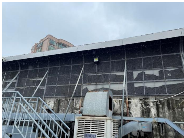
图 4-10 出现破损的噪声污染防治措施
